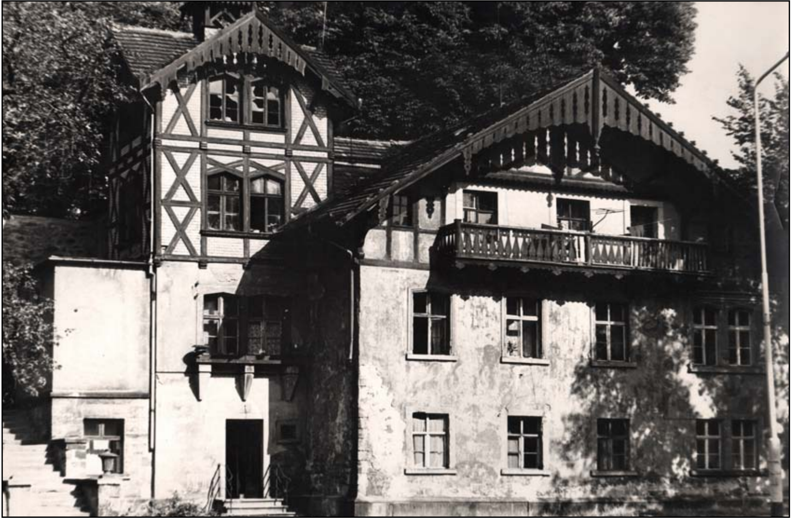
Budynek przy ul. Kubika (nie istnieje), fot. E. Opała, 1969 - 70 r.
