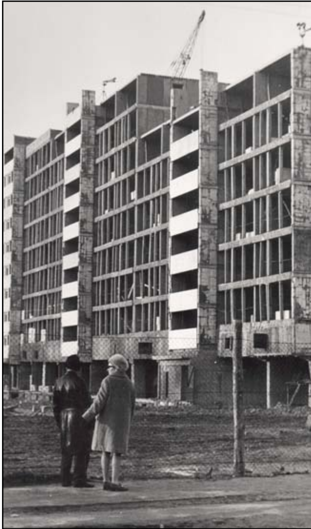
Budowa bloku przy ul. Łukasiewicza, fot. E. Opała
