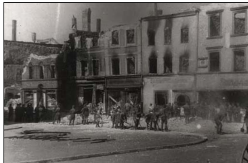
Prace porządkowe przy zachodniej pierzei Rynku, fot. A. lub R. Skorupa, ok. 1946-48 r.
