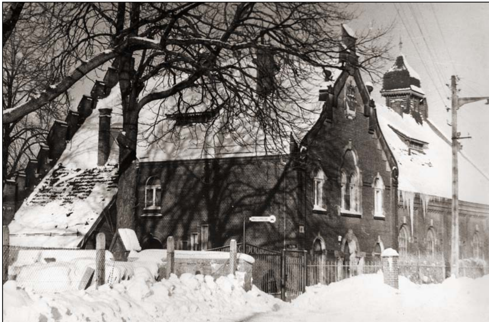
Przepompownia przy ul. Dolne Młyny, fot. B. Marecki
