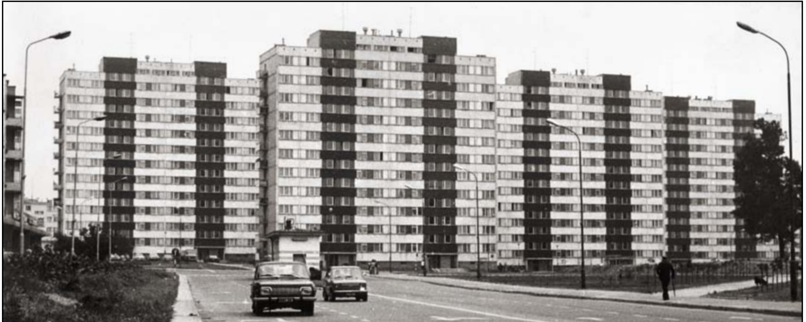
Wieżowce przy ul. Bielskiej, fot. R. Hryciów
