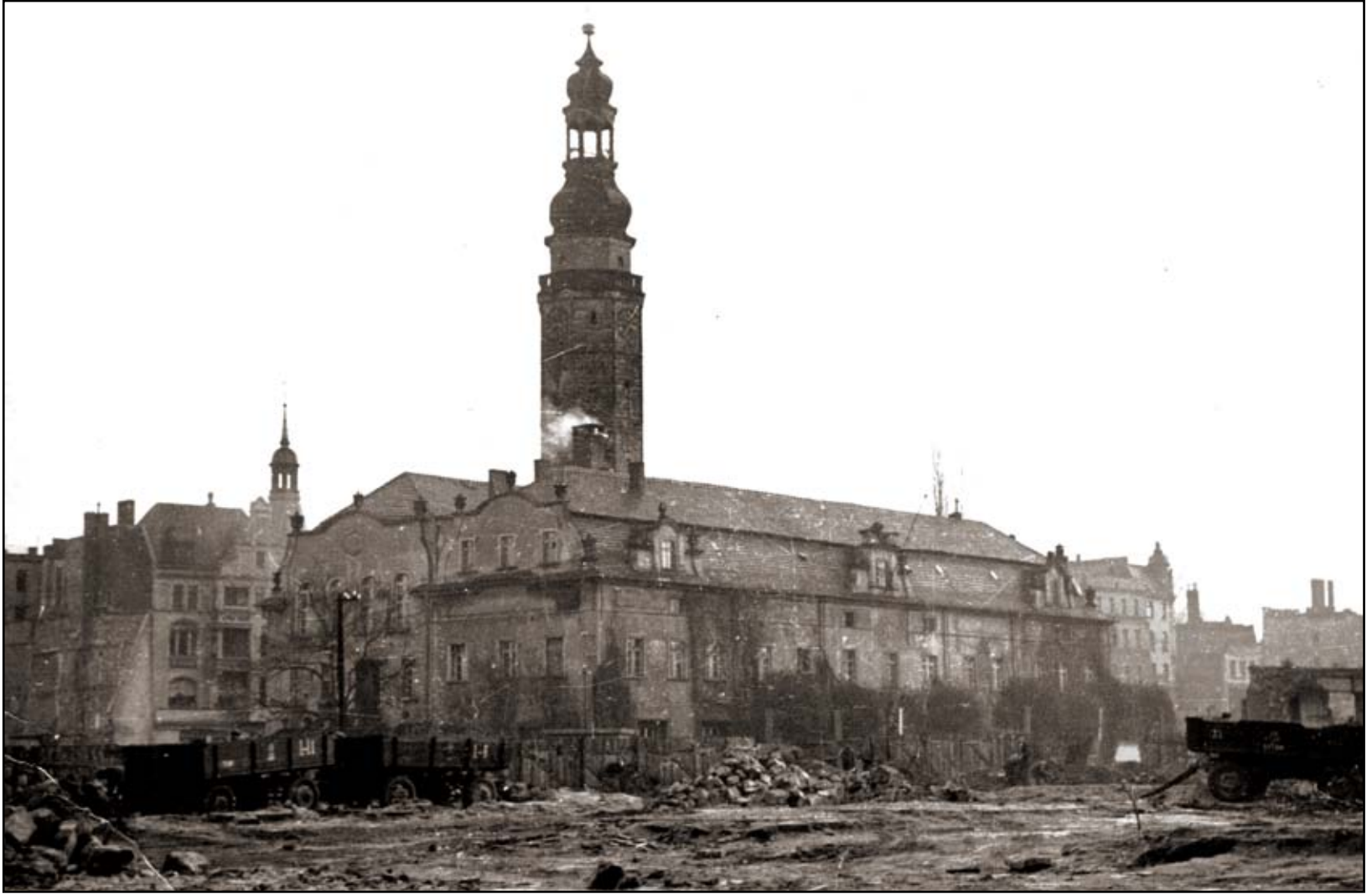
Prace porządkowe w południowo-zachodniej części Ryнку, fot. A. lub R. Skorupa, ok. 1948 r.
