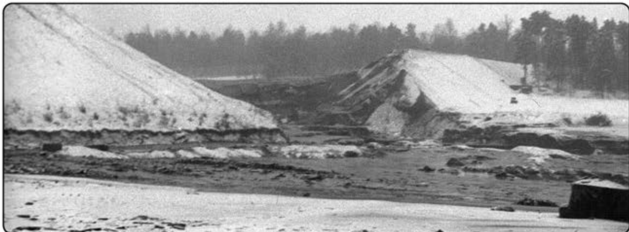
Pęknięta grobla stawu osadowego nr 1.
