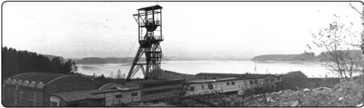
Widok Stawu osadowego nr 1 od strony szybu K-II.
