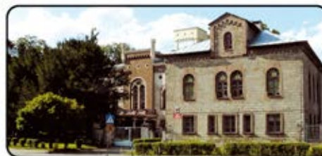
Siedziba dyrekcji PRG i PBKR Bolesławiec fot. J. Paździora
