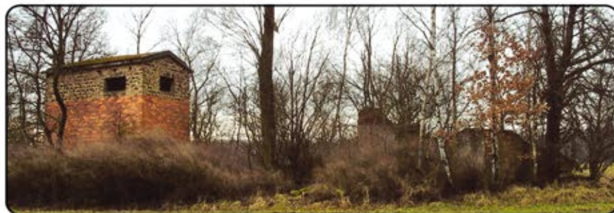
Widok ogólny ruin stacji napędowej kolejki linowej
