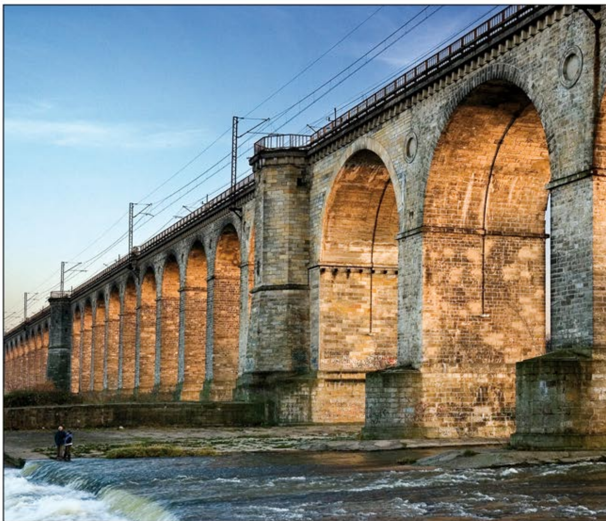
Wiadukt w Bolesławcu
